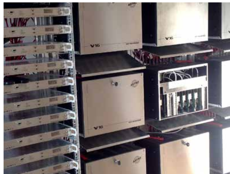
Blick in unsere Kabelkopfstelle in Wilhelmshaven
